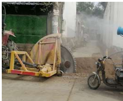
开槽机部分替代挖掘机，降低施工成本
