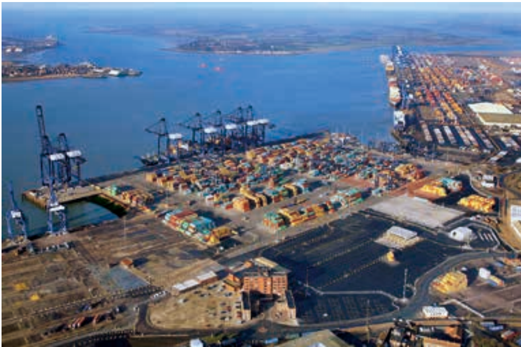
擴建中的菲力斯杜港八號及九號泊位，第一期工程完成後，其水深是全英國貨櫃港之最。
