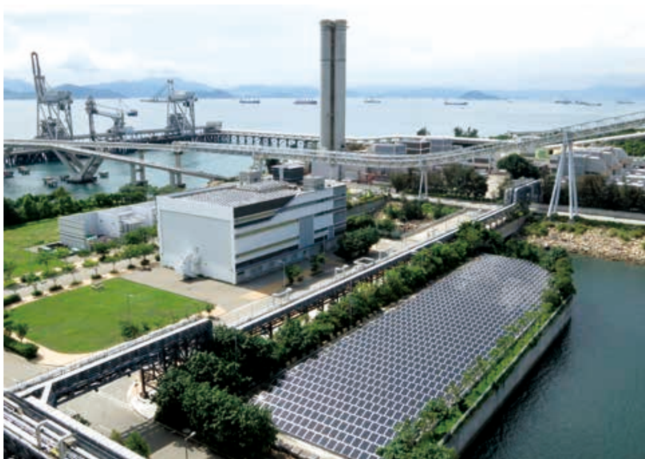
港燈位於南丫發電廠、全港規模最大的太陽能發電系統，發電量現已擴建至一兆瓦。
