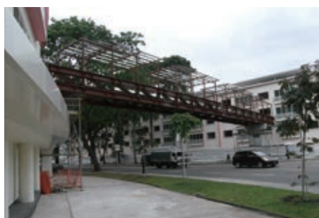
Link Bridge的興建
