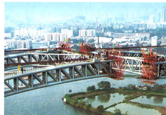
丫髻沙大橋採合先進的工程及建築技術。
