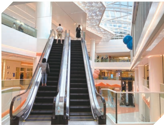
安裝全新的扶手電梯以改善人流。
