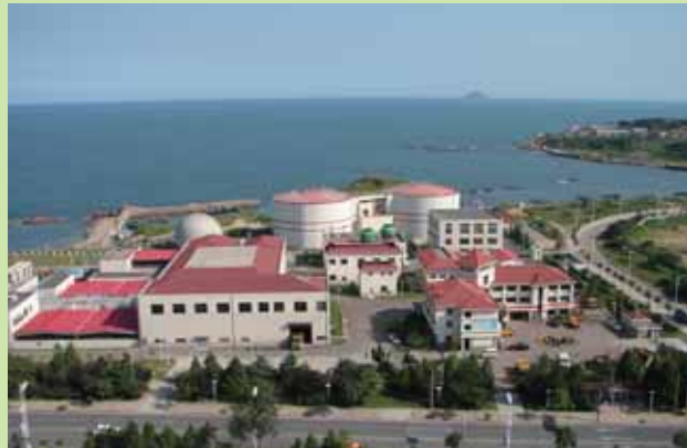
Qingdao Waste Water Treatment Project 青島污水處理項目
