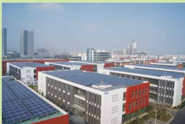
Zhenjiang Rooftop Solar Photovoltaic Energy Project 鎮江屋頂太陽能光伏發電項目
