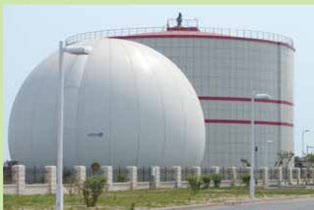
Qingdao Maidaos Sludge Methane-to-energy Project 青島麥島污泥沼氣發電項目
