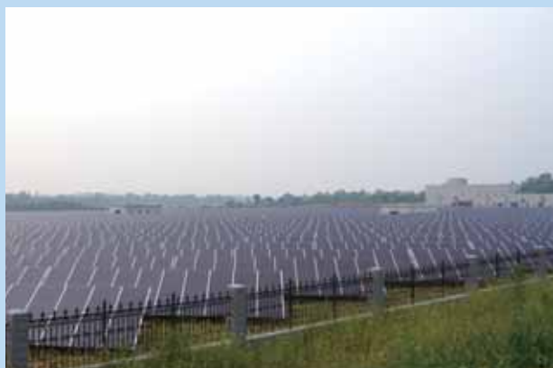
Huaining Ground Solar Photovoltaic Energy Project 懷寧地面太陽能光伏發電項目
