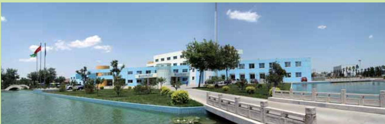
Zibo Waste Water Treatment Project 淄博污水處理項目
