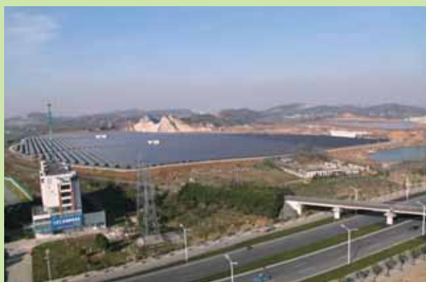
Zhenjiang Ground Solar Photovoltaic Energy Project 鎮江地面太陽能光伏發電項目
