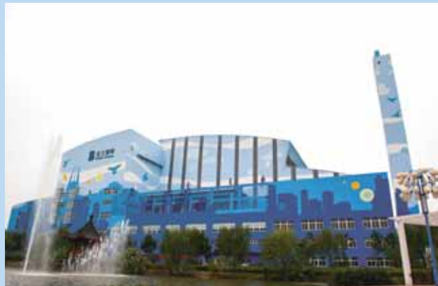
Changzhou Waste-to-energy Project 常州垃圾發電項目
