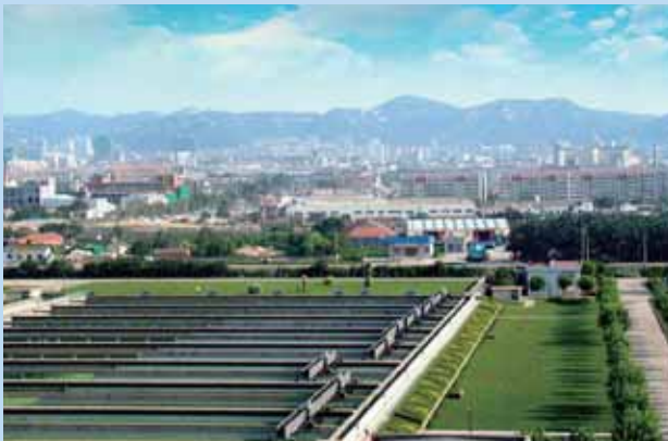
Jinan Waste Water Treatment Project 濟南污水處理項目
