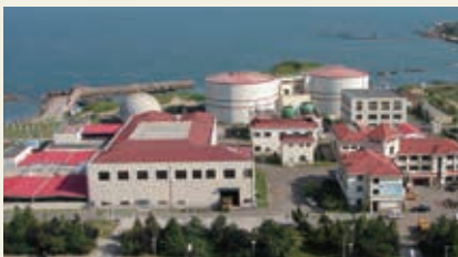
Qingdao Waste Water Treatment Project 青島污水處理項目
