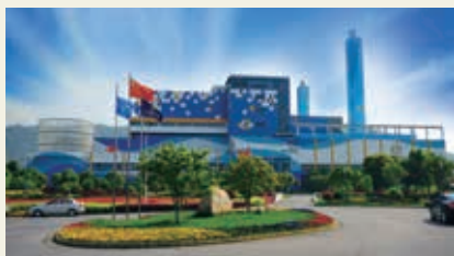
Suzhou Waste-to-energy Project 蘇州垃圾發電項目
