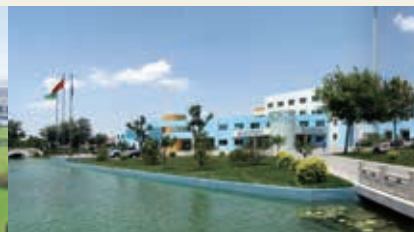
Zibo Waste Water Treatment Project 淄博污水處理項目
