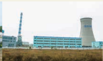
Dangshan Biomass Power Generation Project 礪山生物質能發電項目
