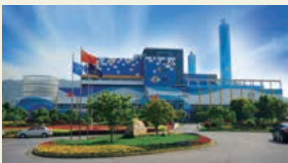
Suzhou Waste-to-energy Project 蘇州垃圾發電項目
