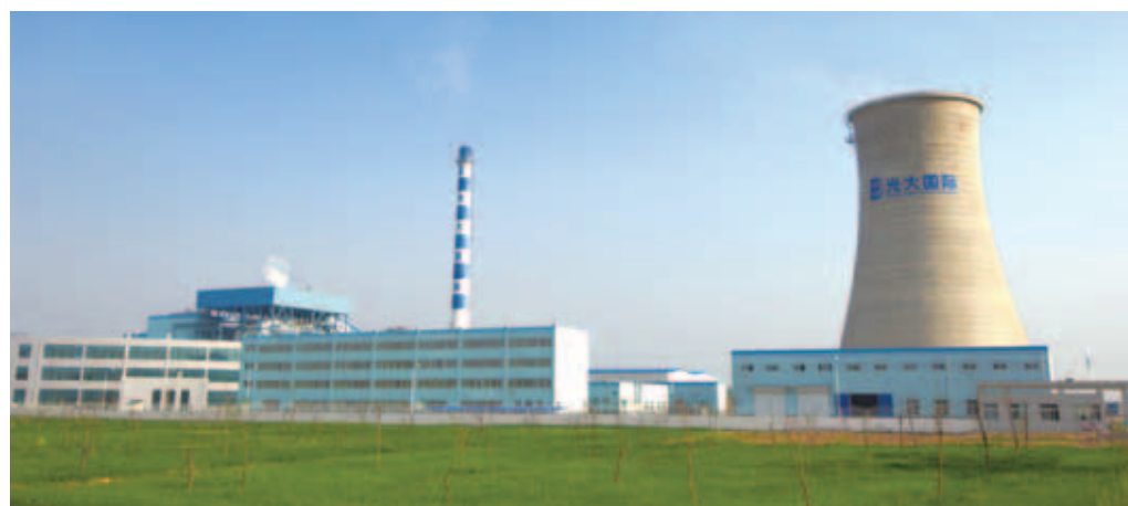
Dangshan Biomass Power Generation Project 碭山生物質能 發電項目
