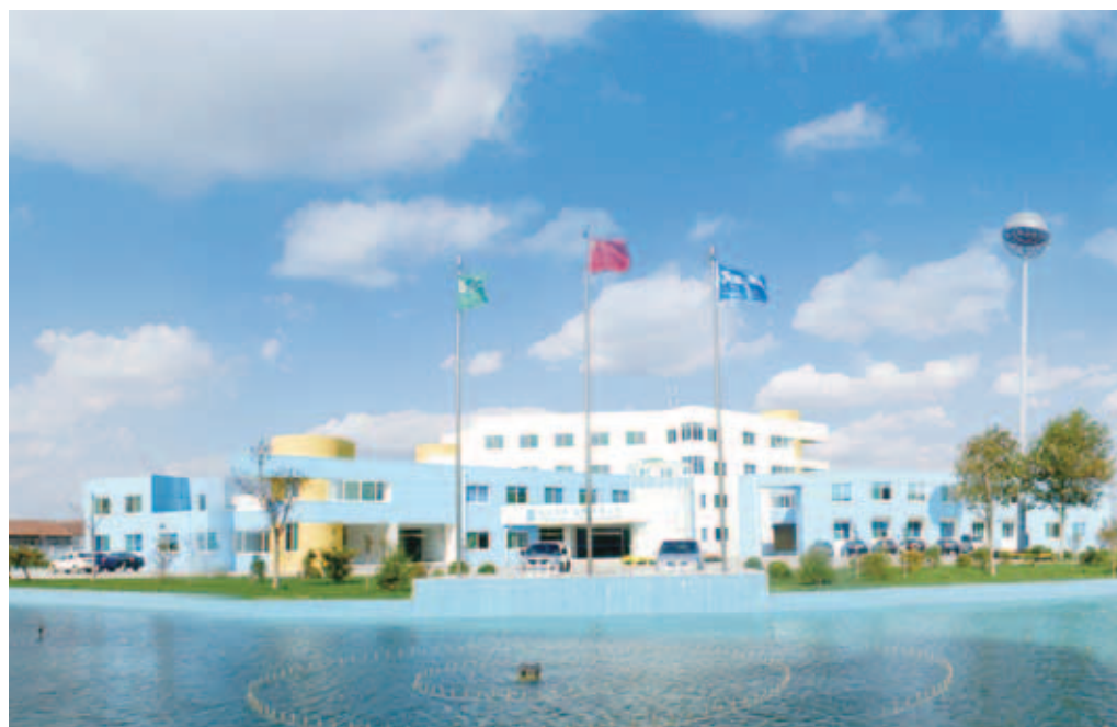
Zibo Waste Water Treatment Project 淄博污水處理項目
