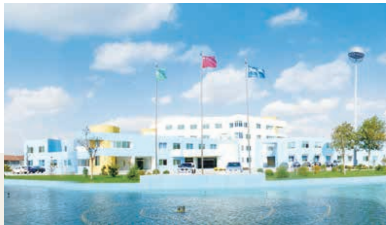
Zibo Waste Water Treatment Project 濰博污水處理項目
