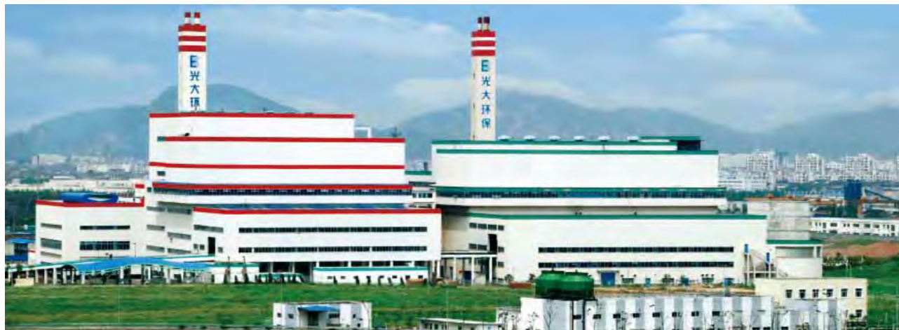
Suzhou Waste-to-energy Project Phase I & II 蘇州垃圾焚燒發電項目一、二期
