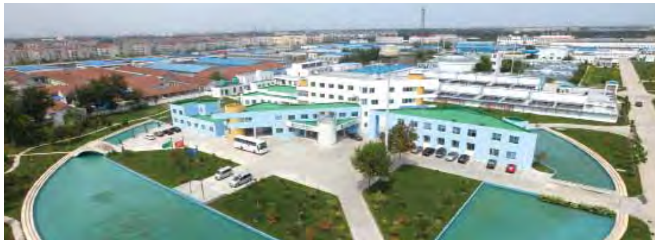
Zibo Waste Water Treatment Project 淄博污水處理項目
