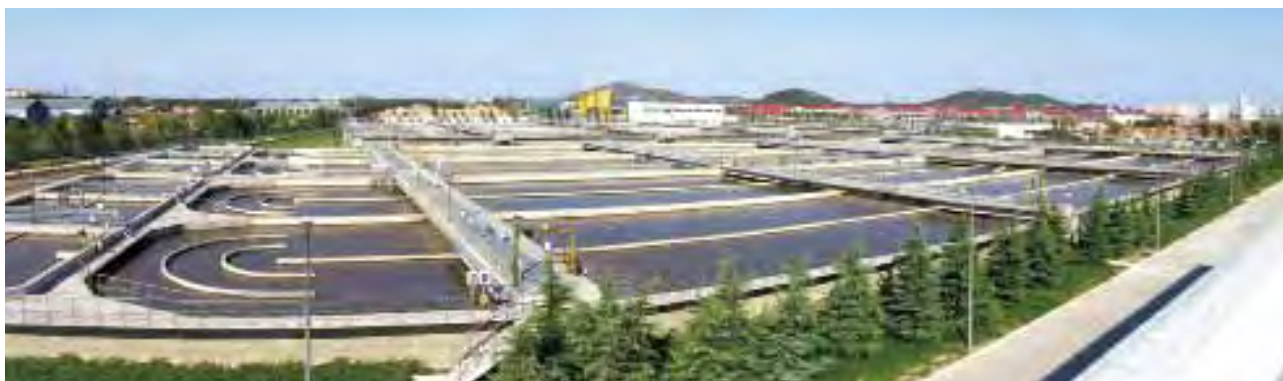
Jinan Waste Water Treatment Project 濟南污水處理項目
