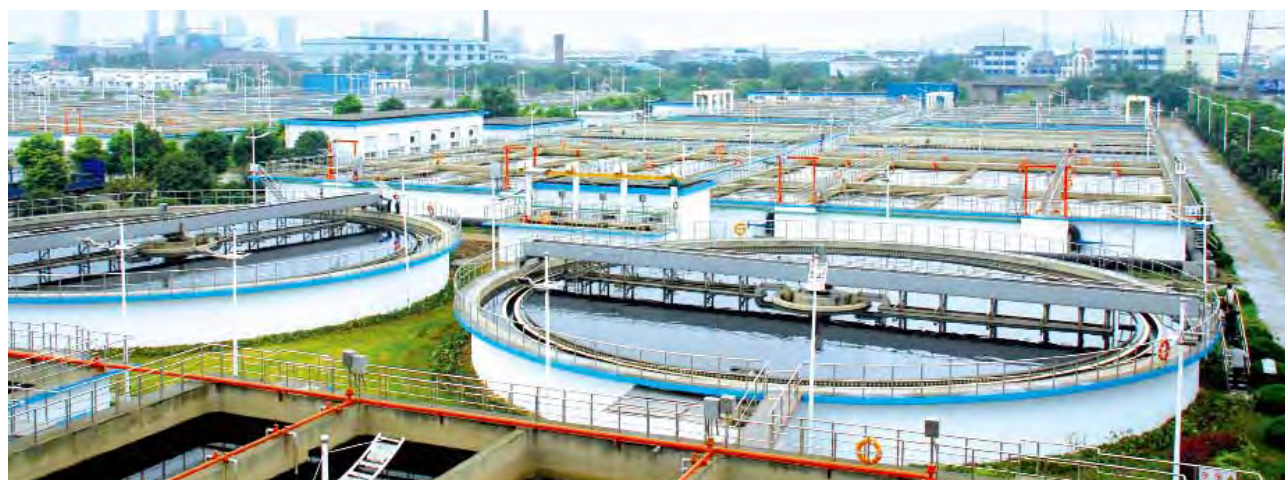
Jiangyin Waste Water Treatment Project 江陰污水處理項目
