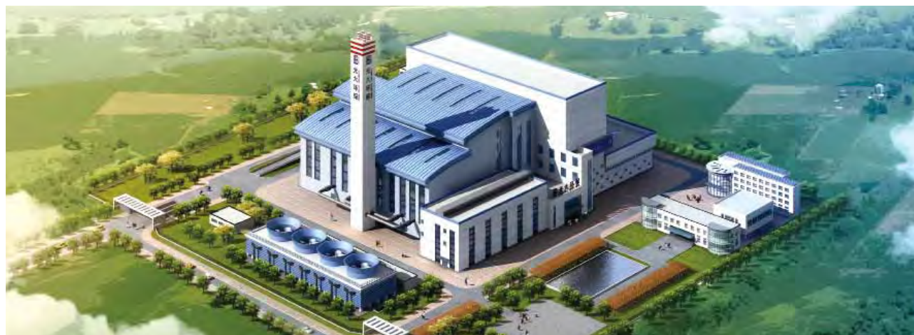
Jinan Waste-to-energy Project 濟南垃圾焚燒發電項目
