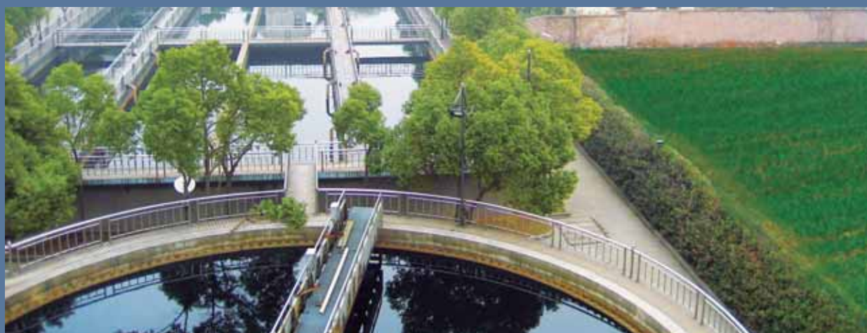
Jiangyin Waste Water Treatment Project 江陰污水處理項目
