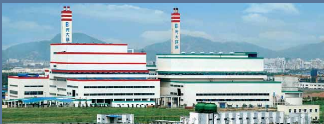
Suzhou Waste-to-energy Project Phase I & II 蘇州垃圾焚燒發電項目一期、二期
