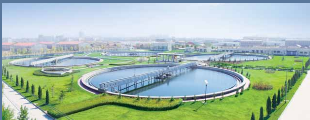
Jinan Waste Water Treatment Project 濟南污水處理項目
