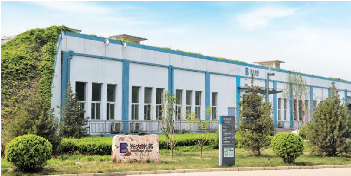
Beijing Daxing Tiantanghe Waste Water Treatment Project 北京大興區天堂河污水處理項目
