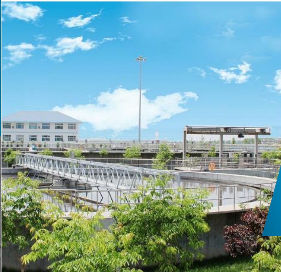
陵城区污水处理项目（一厂） (设计日处理市政污水3万立方米，2010年6月投运)
