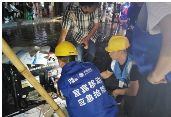
長寧地震後，搶險人員為通信設備發電
