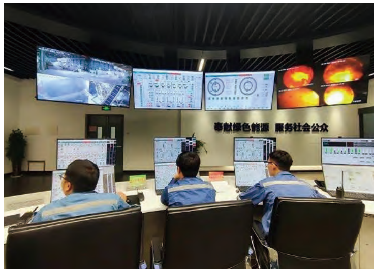
普安發電加強機組運行監視與消缺維護
