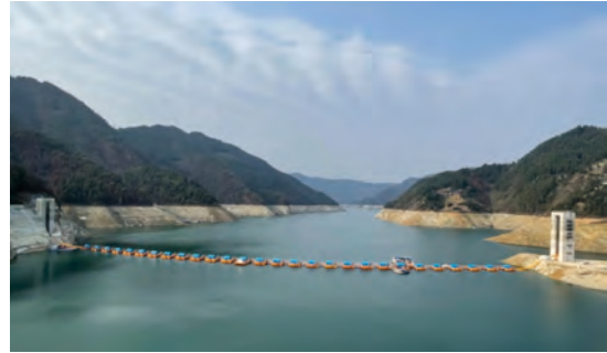
三板溪水電站低溫水治理隔水幕牆試驗工程
