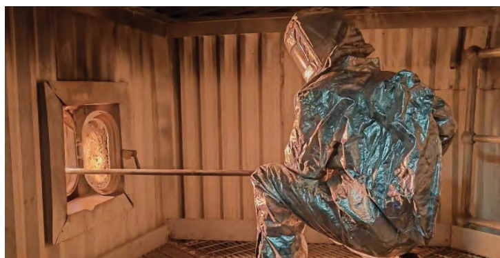
集控巡檢員進行鍋爐看火打焦作業
