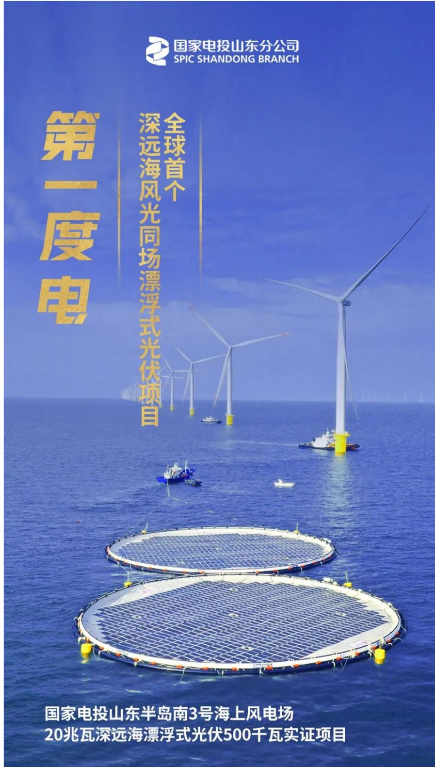
该项目位于山东省海阳市南侧海域，离岸 30 公里，水深 30 米。本次建设的 500 千瓦漂浮式海上光伏由两个环形浮体单元组成，单个浮体单元装机容量 250 千瓦，由环形抗风浪浮体、耐海洋环境的高强薄膜、光伏系统等组成。在直径 53 米，面积相当于 4 个标准篮球场的浮体单元上，共安装 770 块光伏组件，其发出的清洁电力汇流到逆变器后送至同场运行的半岛南 3 号风机平台，后续将通过海上升压站送出。
