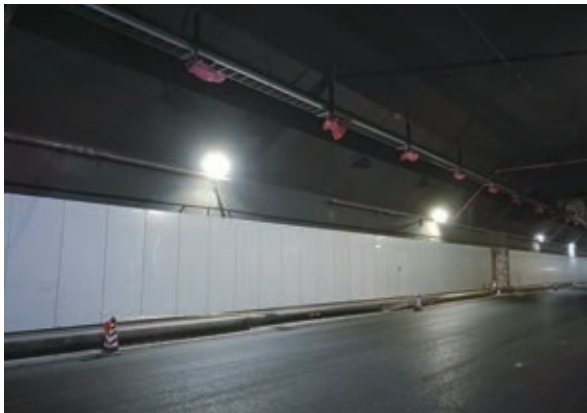
海底隧道室內實景
