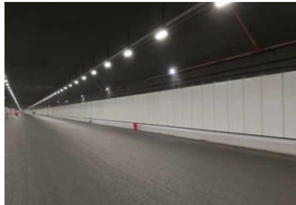
海底隧道室內實景
