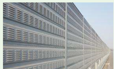
高速公路 / 高鐵隔音屏障
