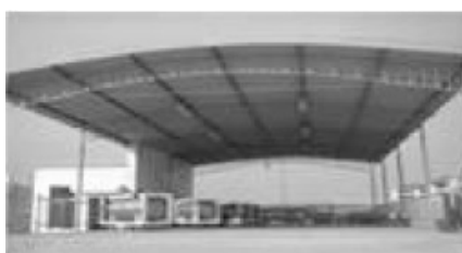
LNG cylinder station
