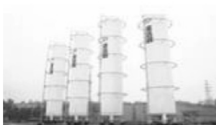
LNG vaporisation stations
