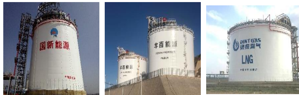
安瑞科承建的部分调峰储备项目分享
