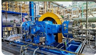
充车母站隔膜压缩机
