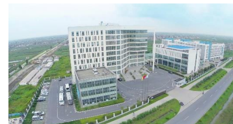
启东 海上氢能事业部
