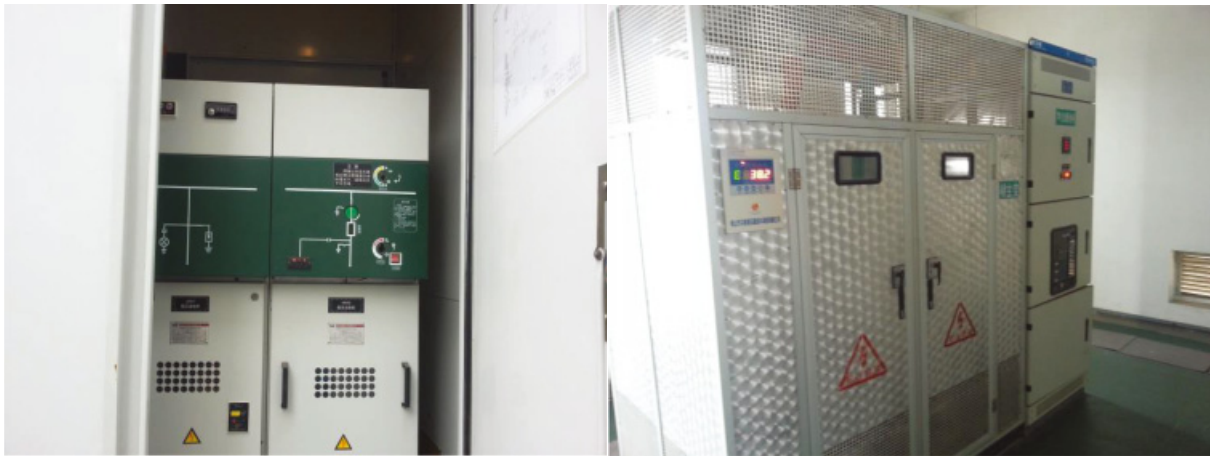
圖6.3廠區廠房設備示例 (典型光伏陣列支架系統及換流器系統)
