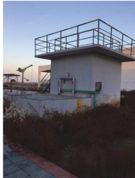
污水站—污泥槽
