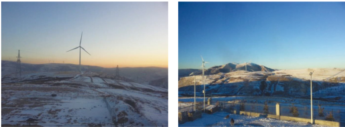
圖7.1寧武風電風力發電機組
