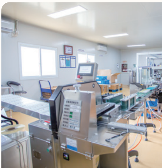
同方藥業集團有限公司之生產設備 Production equipment of Tongfang Pharmaceutical Group Co., Ltd*
