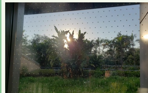
美孚站100多幅玻璃幕牆安裝防鳥撞窗貼紙
