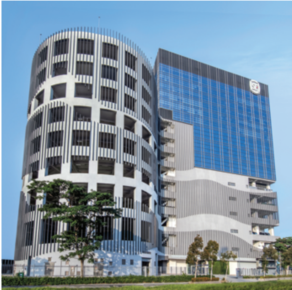
Asia Logistics Hub – SF Centre (亞洲物流中心-順豐大廈)
