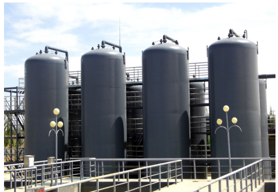
廢氣處理設施
