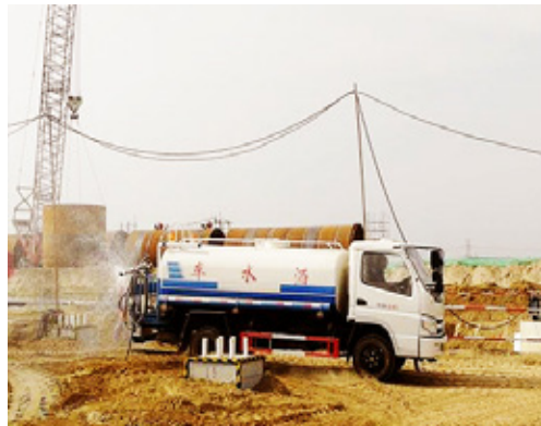
施工區域灑水除塵
