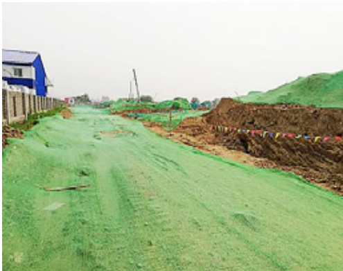
現場裸土覆蓋
