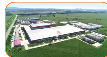
抚顺奶粉厂项目
