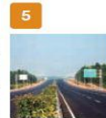
5 西二環高速公路
