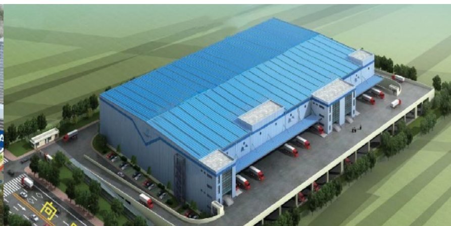
上海闵行冷库项目（已竣工投产）
