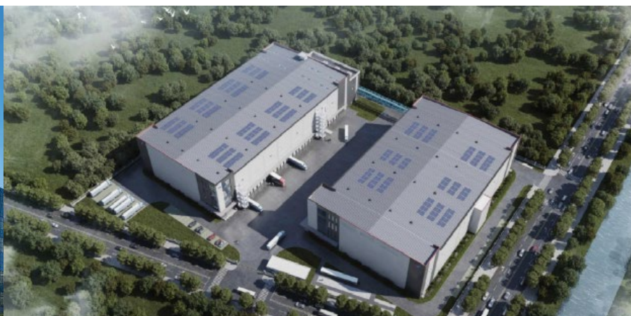
南京江宁空港冷库项目（2024年底竣工投产）
