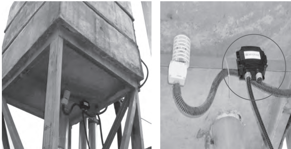
圖19：戶外溫度及濕度傳感器(安裝於樓宇屋頂膨脹箱下，毗鄰冷卻塔)
