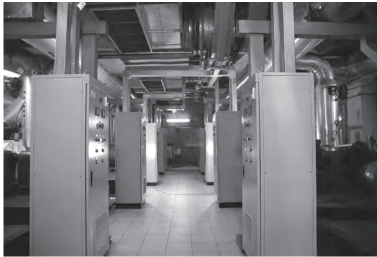
圖22：一次冷水及冷卻水泵之VSD板
