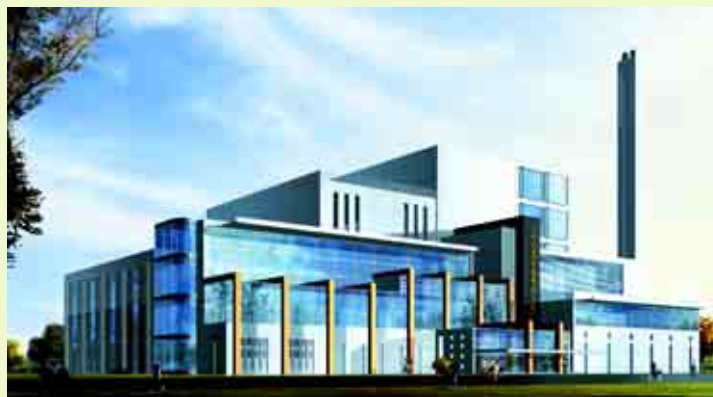
宜興垃圾焚燒發電廠
