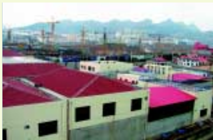
Qingdao Maidaowaste Water Treatment Plant (Extension Facilities) 青島麥島污水處理廠（擴建工程）
