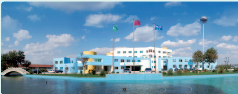
Zibo Waste Water Treatment Project 淄博污水處理項目
