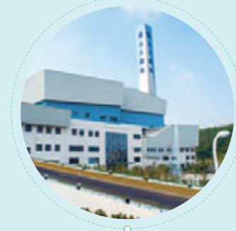
Ningbo WtE Project 寧波垃圾發電項目
