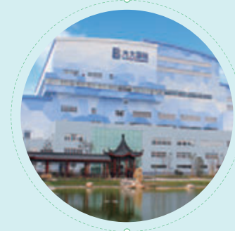
Zhenjiang WtE Project 鎮江垃圾發電項目
