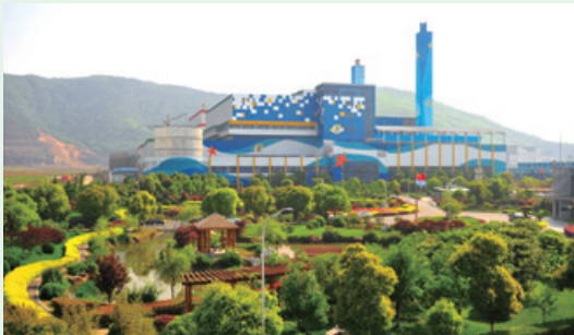
Suzhou Waste-to-energy Project 蘇州垃圾發電項目
