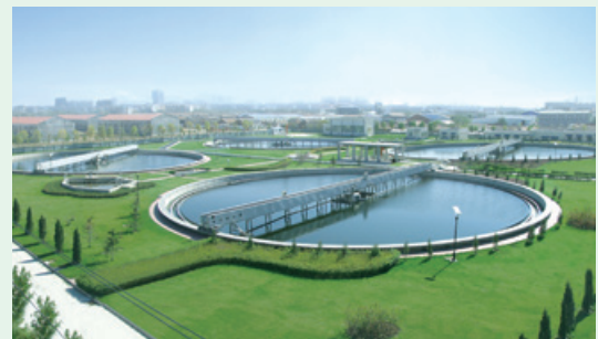
Jínan Waste Water Treatment Project 濟南污水處理項目
