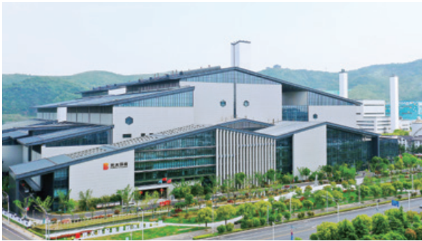
Suzhou Waste-to-energy Project 蘇州垃圾發電項目
