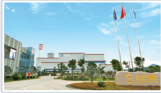
Nanjing Waste-to-Energy Project 南京垃圾發電項目
