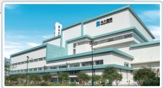
Rizhao Waste-to-Energy Project 日照垃圾發電項目
