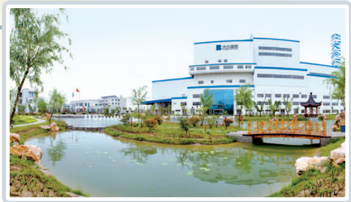
Suqian Waste-to-Energy Project 宿遷垃圾發電項目
