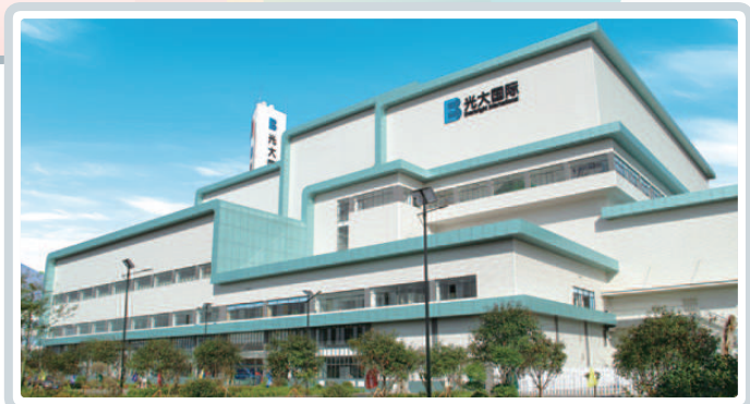
Rizhao Waste-to-Energy Project 日照垃圾發電項目
