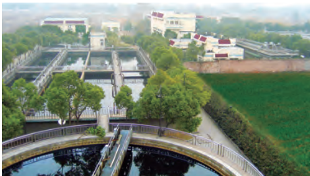
Jiangyin Waste Water Treatment Project 江陰污水處理項目
