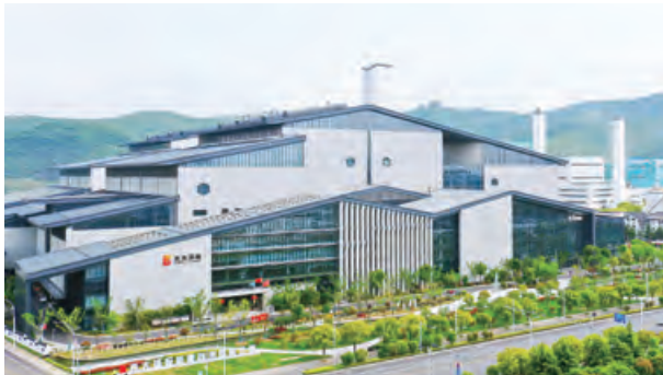
Suzhou Waste-to-energy Project 蘇州垃圾發電項目
