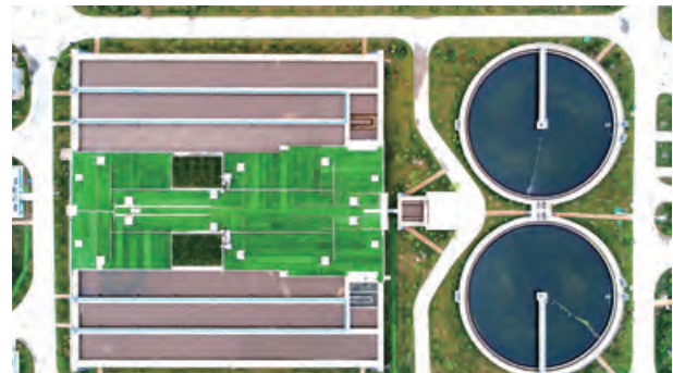
Ji'nan Waste Water Treatment Project 濟南污水處理項目
