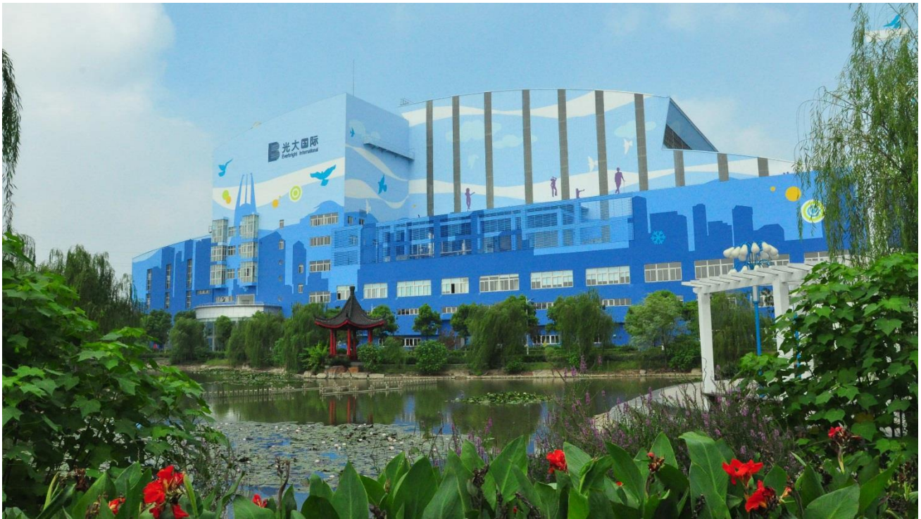
江蘇常州生活垃圾焚燒發電廠
