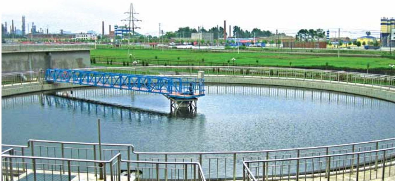
Liaoning Dandong Waste Water Treatment Project 遼寧丹東污水處理項目
