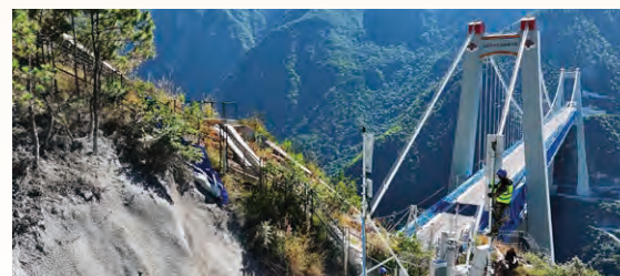
虎跳峽金沙江鐵路大橋基站建設
