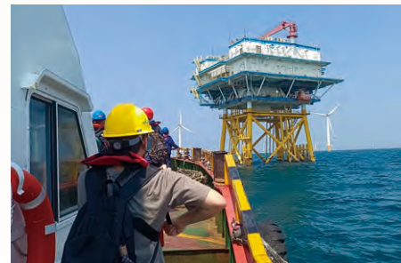
廣東省陽江市海上風電平台 5G 基站建設
