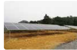
修建的光伏电站
