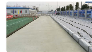
• 绿色施工扬尘控制
