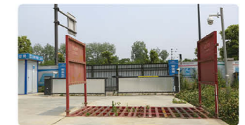
• 施工车辆水冲洗装置
