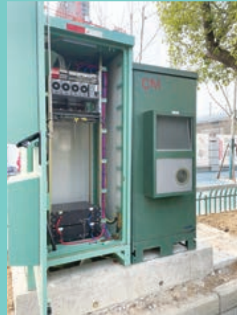
拆舊開關電源利舊站點
