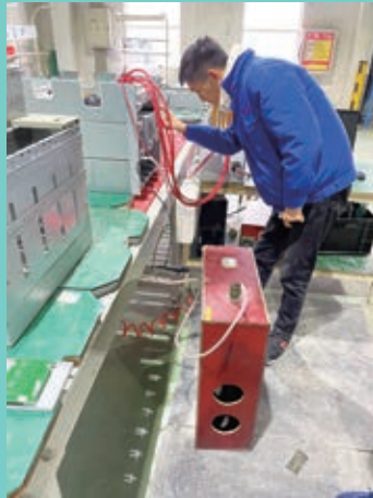
拆舊開關電源改造檢測
