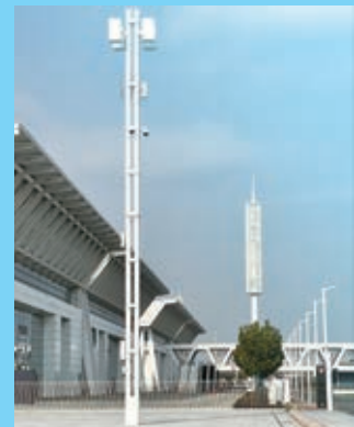
利用燈桿建設通信塔
