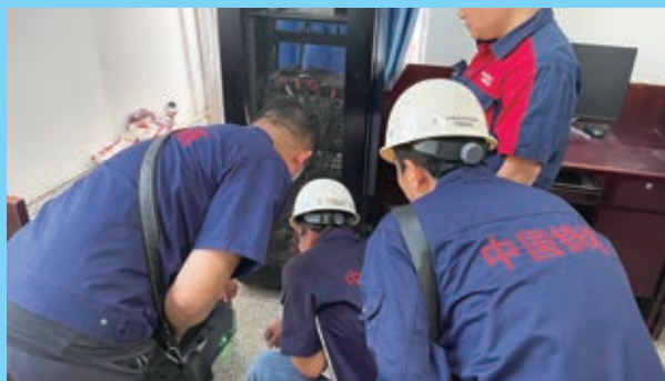
保電現場作業
