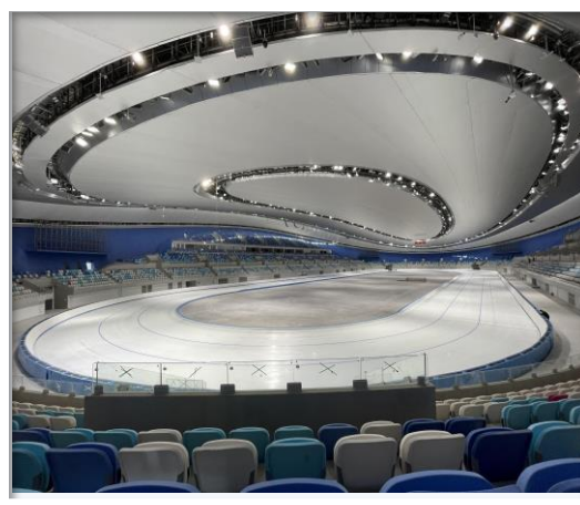
室内外协同 建设冬奥场馆5G覆盖
